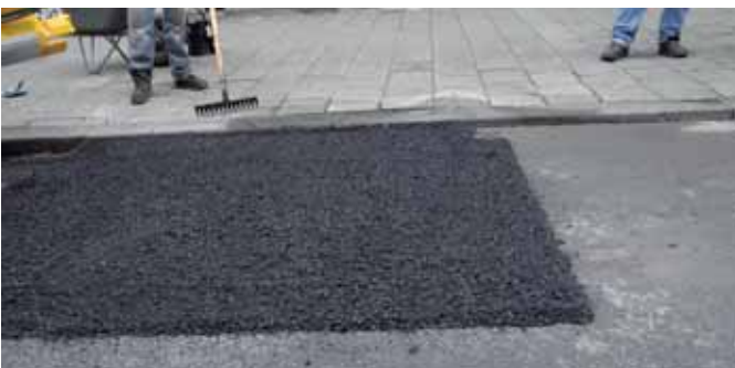
Zonder noemenswaardige inspanning is precies de juiste hoeveelheid asfalt aangebracht.
