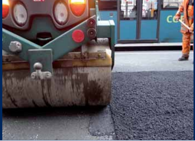
Aandrukken van het nieuwe asfalt tegen het bestaande asfalt.
