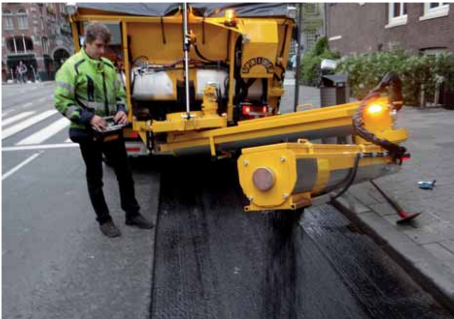
Principe: Twee zwenkbare balken met een wormwiel.
