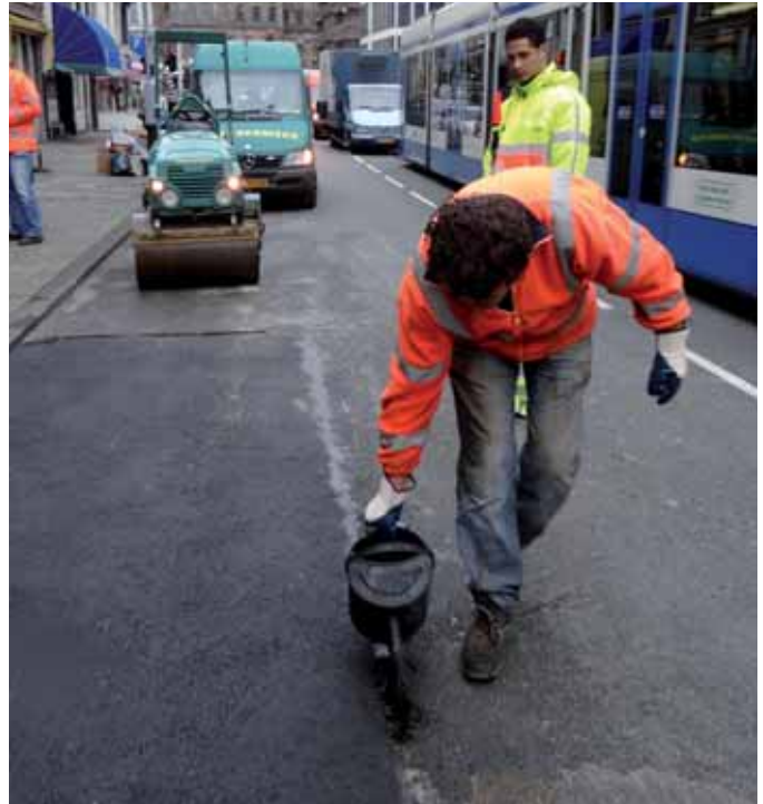
Gieten van bitumenemulsie over de naad.
