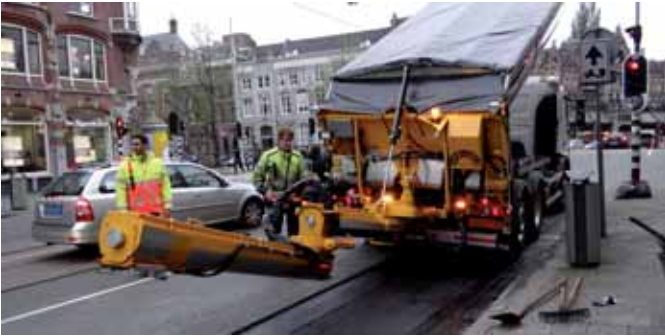
De operator brengt de spreidbalk in positie.
