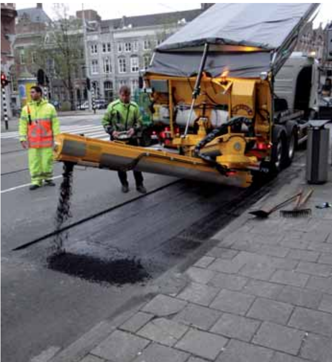
Zorgvuldig verdeelt de operator het asfalt op de juiste dikte in het vak.
