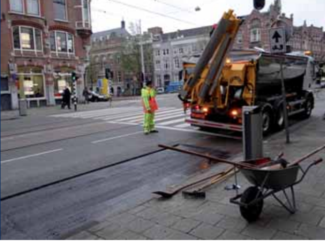
Sprider komt aan bij het reparatievak.
